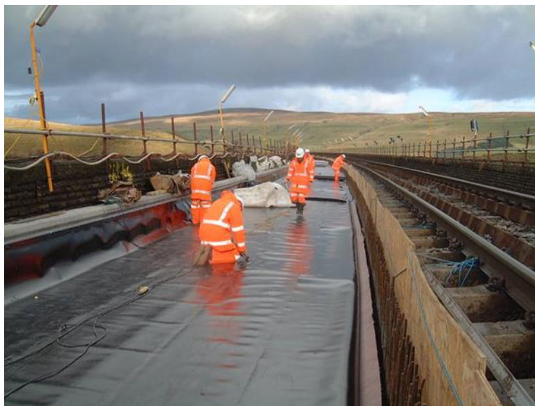
Figura 12.8.4.2.2 - Lavorazione con il 2° binario in affianco sostenuto
