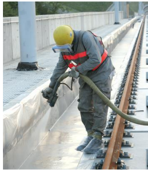
Figura 12.8.4.2.6.a - Applicazione a spruzzo della membrana impermeabile
